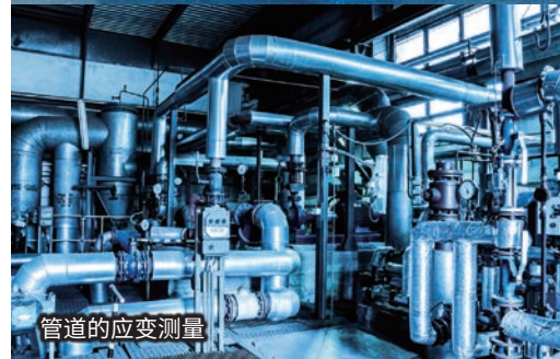
制动和配管的应变测量
